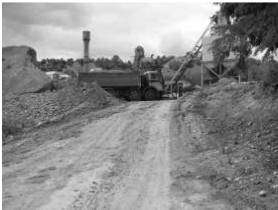
Εικόνα 1. Γειτονικό εργοστάσιο ασφάλτου
