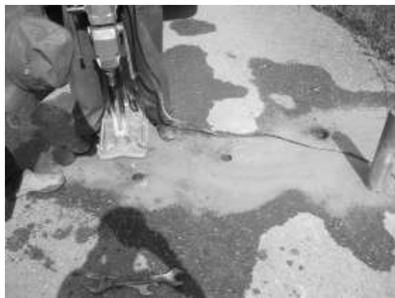
Εικόνα 4. Πυρηνοληψία σε θέση με ασφαλτική επικάλυψη
