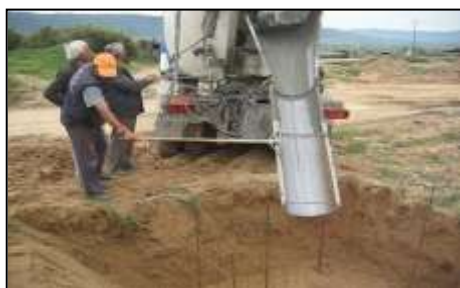
Εικόνες 8, 9. Δοκιμαστική διάστρωση σκυροδέματος.
