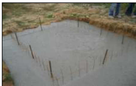
Εικόνες 8, 9. Δοκιμαστική διάστρωση σκυροδέματος.
